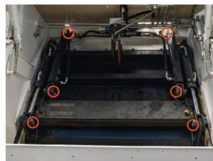
Оси гидроцилиндров плит
